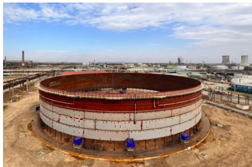
Constanta Romania LNG Tank, 76 m diameter, 490,000 barrels
